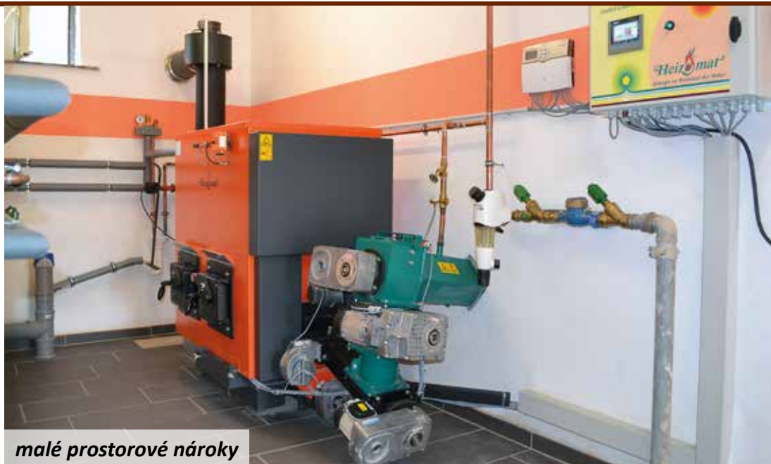
automatické odpopelňování spalinové komory
